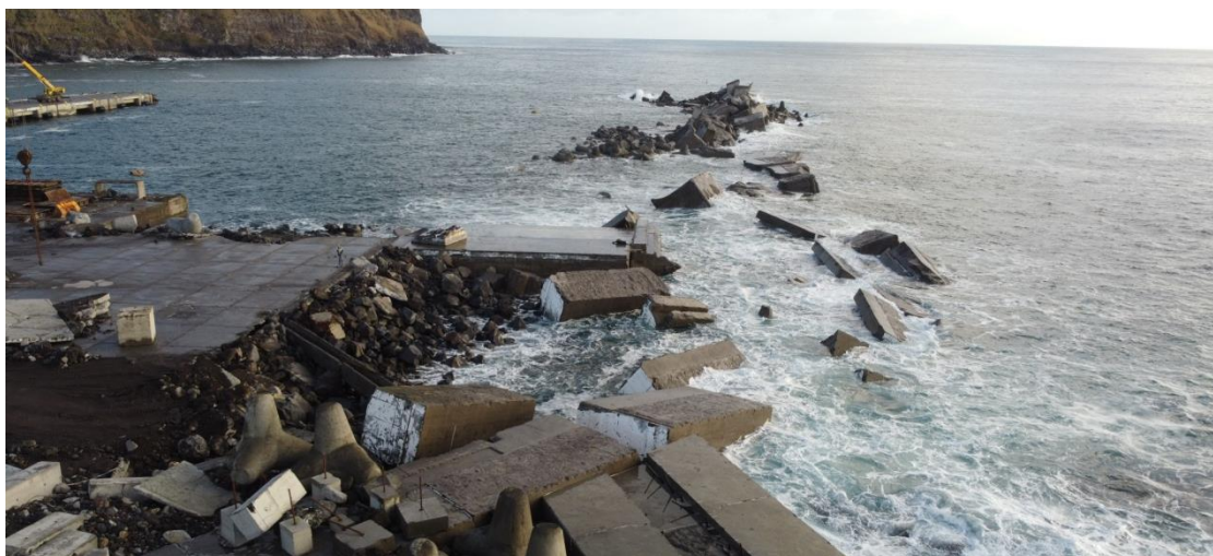
Figura 4 – Situação após a passagem da depressão Efrain
