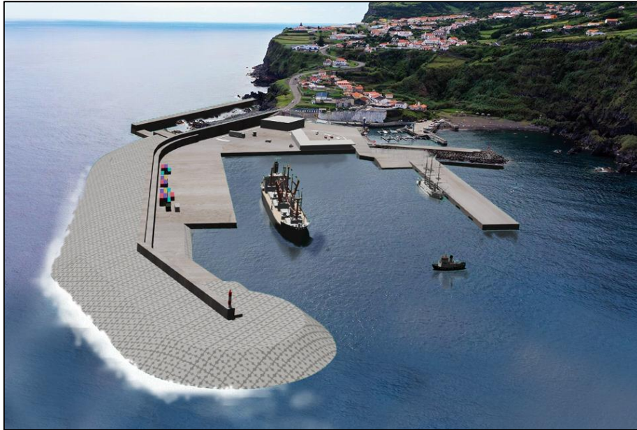
Figura 17 – Construção do Porto Novo das Lajes das Flores – Fotomontagem 3D
