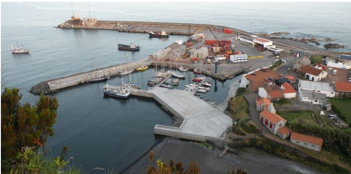
Figura 1 – Situação do porto antes da passagem do furacão Lorenzo
