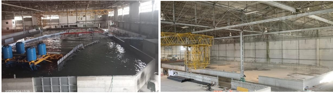
Figura 1 – Novos Tanques TOI1 (esquerda) e TOI2 (direita)
