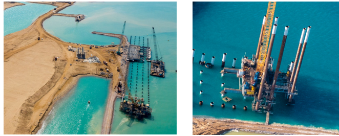
Figura 6 – Cravação das estacas metálicas.
