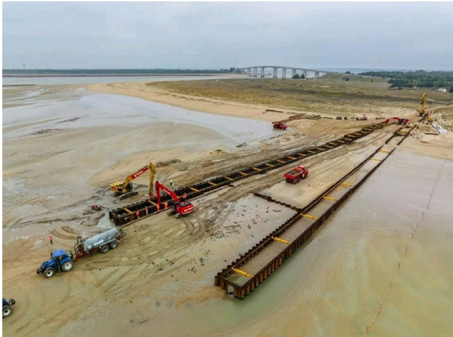
Figura 5. Obras temporárias para instalação de cabos submarinos
