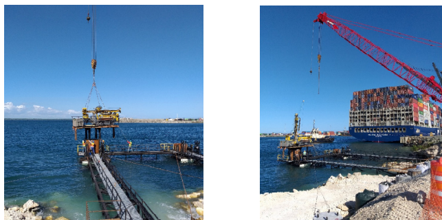
Figura 3 - Execução das estacas da cortina de contenção
