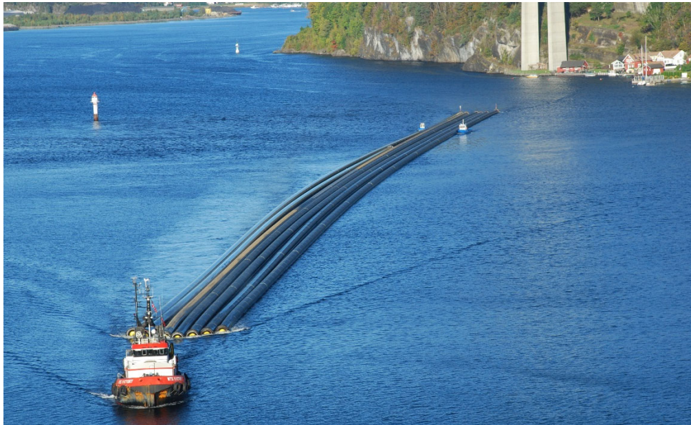
Figura 1: Partida dos tubos de PEAD desde a Noruega – Cortesia da Pipelife Norge AS
