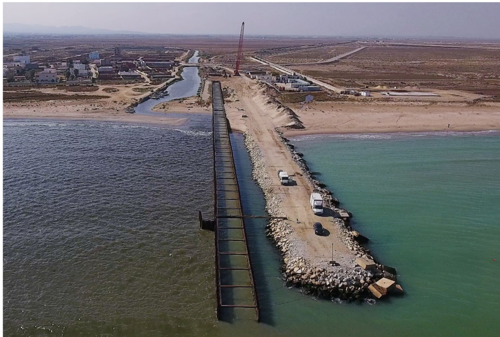
Figura 2: Trabalhos temporários constituídos por um esporão temporário e cortinas de estacas-prancha
