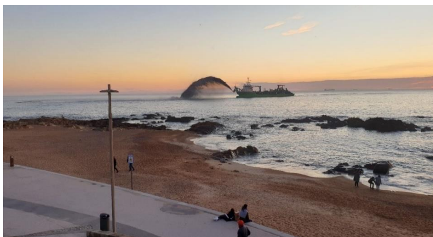
Figura 5. Processo de descarga da TSHD Meuse River pelo método de Rainbowing na Área 3.
