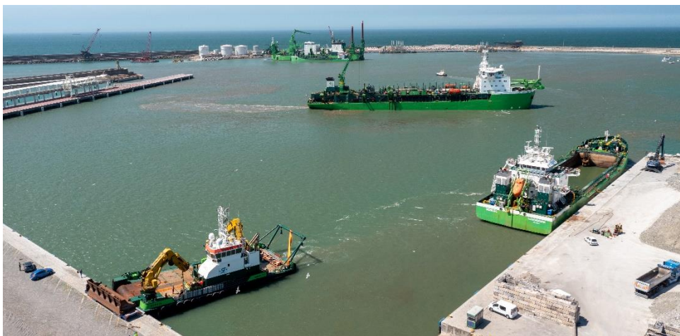
Figura 8 – CSP Spartacus em operação no Porto de Leixões efectuando a carga da SHB Deugniet, SHD Bengel em standby, TSHD Nile River em operação, Lancha de Batimetria Geo Connection e Multicat Auxilia.
