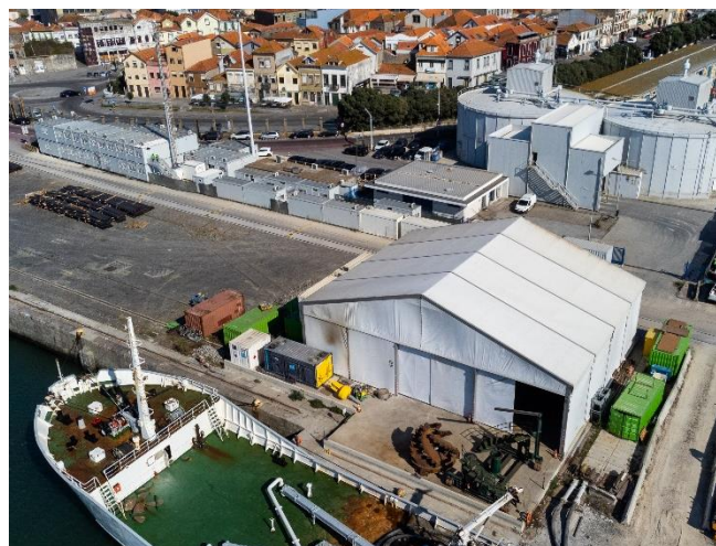
Figura 10. Oficina de reparação de cabeça de corte no interior do Porto de Leixões.
