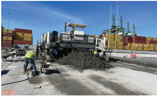
Imagem da frente da pavimentadora de betão
