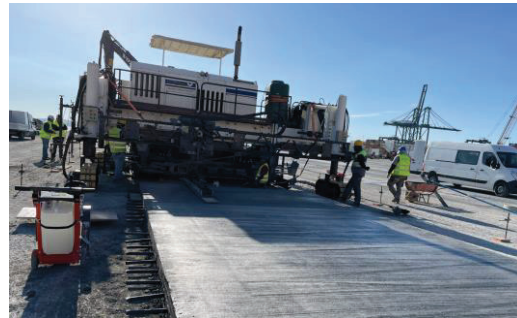
Imagem da traseira da pavimentadora de betão – pavimento acabado
