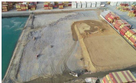
Execução do aterro de pré-carga
