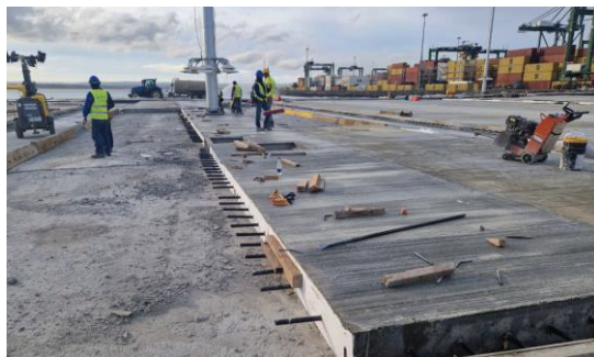
Imagem da junta longitudinal e preparação para corte de junta transversal
