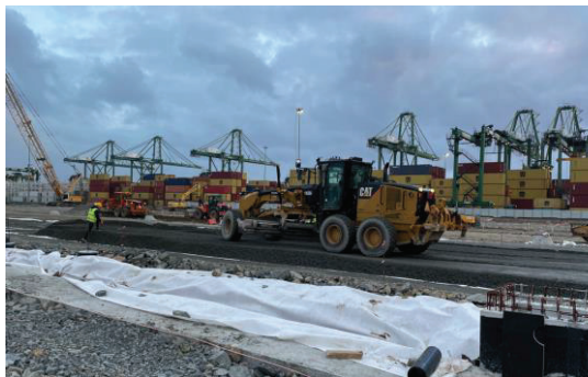
Primeira camada de ABGEC - niveladora
