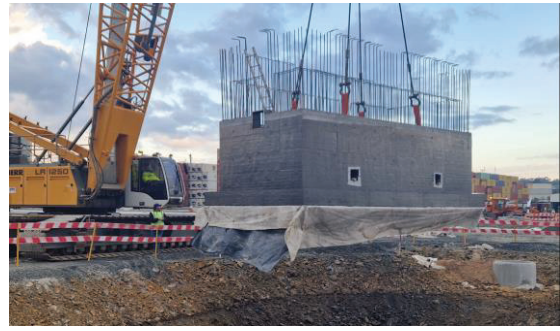
Instalação das caixas em betão – foram parcialmente pré-fabricadas em estaleiro
