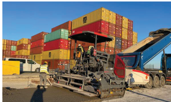
Segunda camada de ABGEC - pavimentadora
