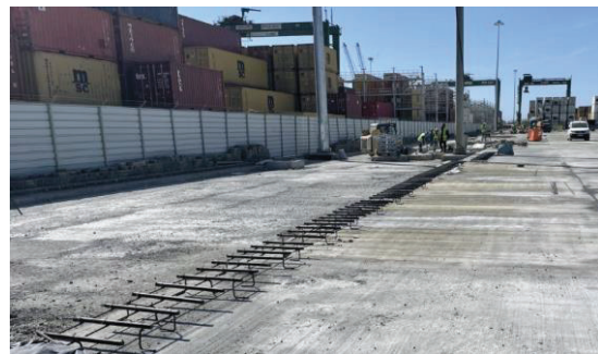
Cavaletes para os varões de transmissão aplicados transversalmente
