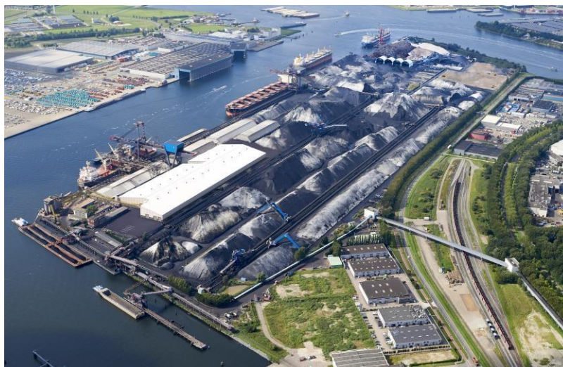
Figura 3. Vista aérea do HBTA (HES International, 2025)
