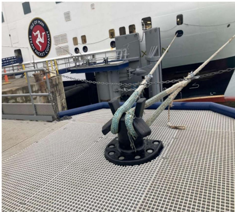
Figura 4. Duque D'alba de acostagem (SD1/PD1) em construção com vista para a defesa Parallel Motion Fender.
