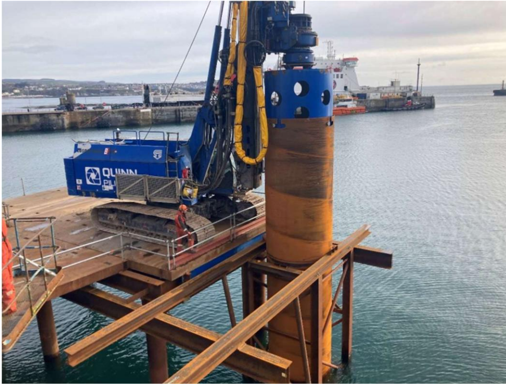
Figura 5. Duque D'alba de acostagem (SD1) em construção.
