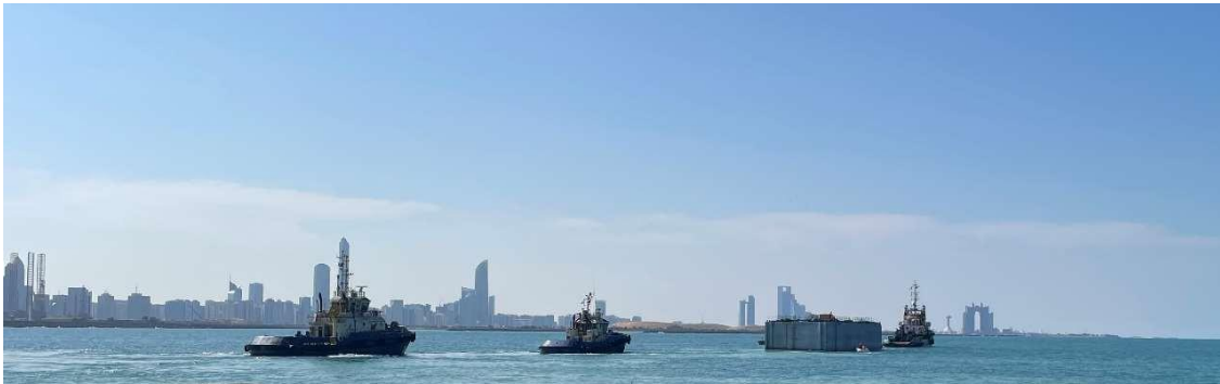
Figura 3. Transporte do caixotão para o local da obra.
