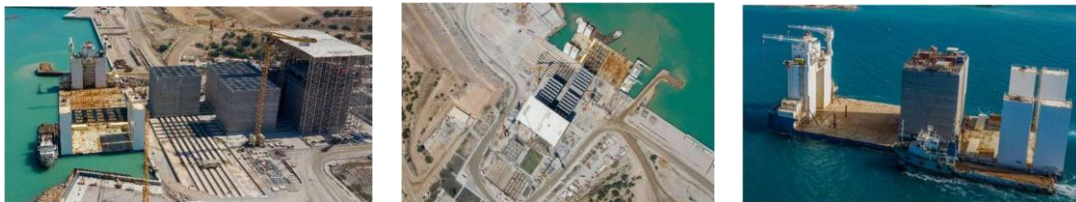
Figura 6 – Área de pré-fabricação (esquerda e centro). Transporte dos caixotões (direita).
