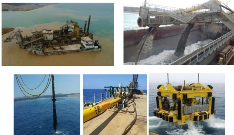
Figura 5 – Equipamento de dragagem (cima), equipamento de vibrocompactação (em baixo esquerda) e equipamento para a execução de ensaios CPTu.
