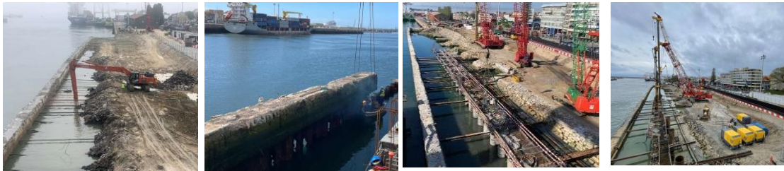
Figuras 5, 6, 7 e 8 - Remoção do enrocamento e dos blocos de cais cortados com fio diamantado (esquerda) Execução de estacas com martelo de fundo de furo “DTH” (direita).
