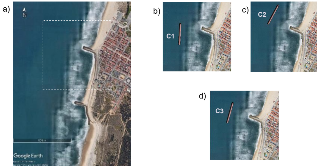
Figura 1. (a) Vista geral das obras costeiras no Furadouro; (b-d) localizações dos quebra-mares destacados ensaiados no Furadouro (cenários C1, C2 e C3)
