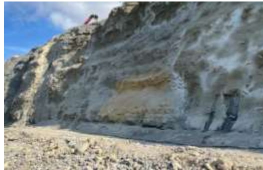
Figura 3 – Corte tipo e exemplo de aplicação de betão projetado pigmentado e pregagens
