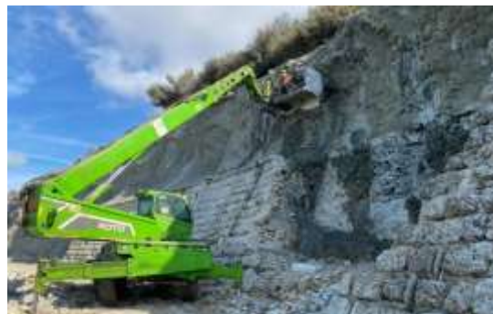
Figura 5 – Corte tipo e exemplo de reconstrução de muralha com pedra argamassada
