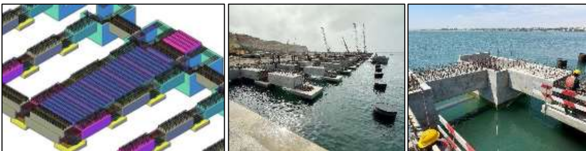
Figura 3. Esquema de montagem dos prefabricados e imagens da colocação em obra.
