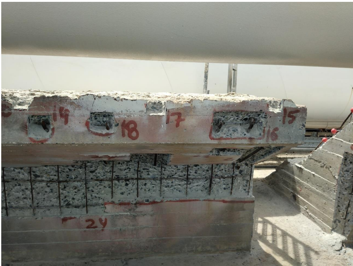
Figura 1. Processo de reparação de estruturas de betão armado.
