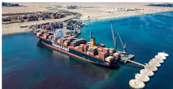
Figura 2. Quebra-mar em Mejillones, Chile (ArcelorMittal, 2021).
