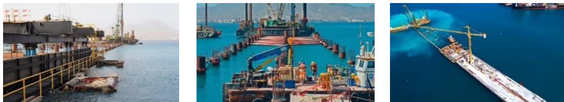
Figura 3. Terminal de Cruzeiros do Mindelo, Jetty de Cruzeiros: (a) e (b) sistema de pórticos modulares durante a construção e (c) perspetiva geral da obra do jetty.
