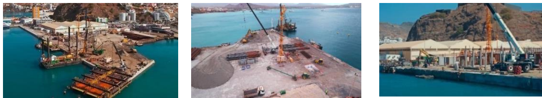
Figura 4. Terminal de Cruzeiros do Mindelo, Bridge, Dragagens e Reabilitação do Cais da Pesca: (a) e (b) aterro técnico (LandBridge) e (c) reabilitação do cais da pesca (Cais 9).
