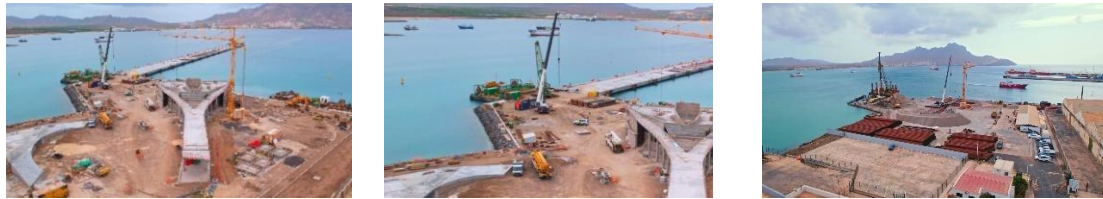
Figura 5. Terminal de Cruzeiros do Mindelo, construção da obra: (a) edifício de receção, (b) landbridge e jetty e (c) vista geral do local da obra.
