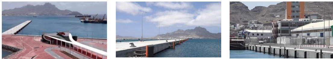
Figura 1. Terminal de Cruzeiros do Mindelo, em São Vicente: (a) vista geral das novas obras com edifício de receção, (b) novo jetty de acostagem dos navios e (c) cais de pesca reabilitado e reapetrechado.
